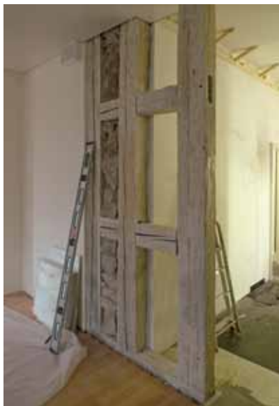
Der Flur des ehemaligen Forsthauses in Bad Herrenalb vor Beginn der Spanndeckenmontage
