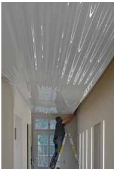
Martin Franzwa bei der Montage der weißen Spanndecke von Ciling im Flur der heutigen Zahnarztpraxis
